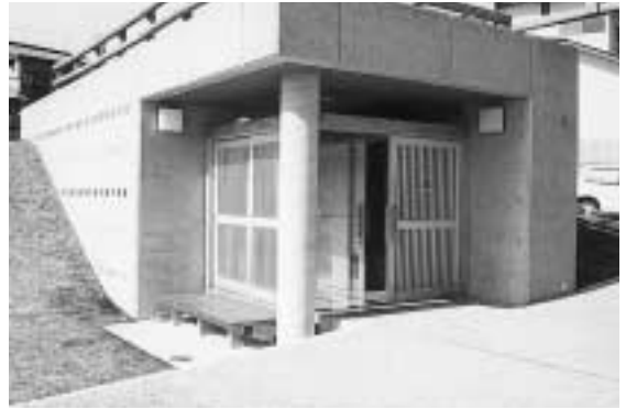
住民参加による靴を脱いであがる公衆トイレ
